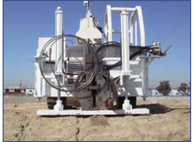
Mini CPT shown here on all-terrain drill rig.
